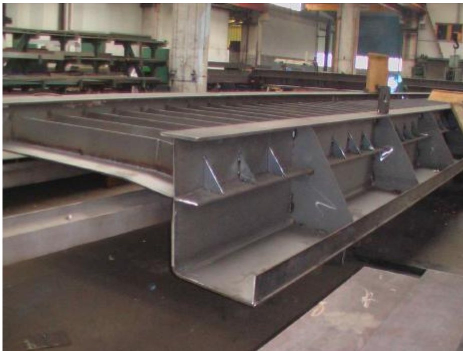
6. kép: a Remetei Fekete-Kőrös híd új ortotróp pályalemezének gyártása
