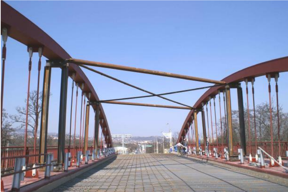
12. kép: rudak helyett nyomott segédoszlopok és merevítés a betoláshoz
