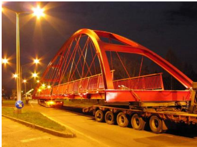
4. kép: az acél felszerkezet helyszínre szállítása
