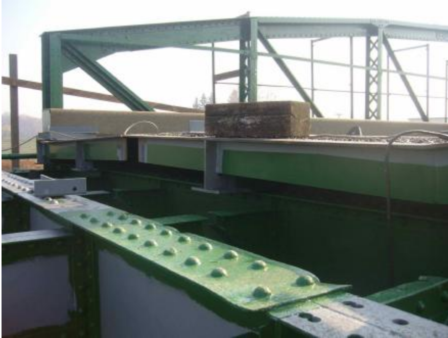
7. kép: az új ortotróp pályalemez elhelyezése
