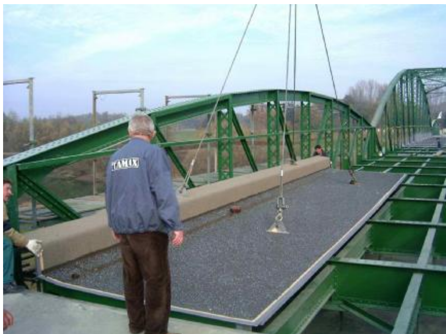
8. kép: pályatábla beemelése
