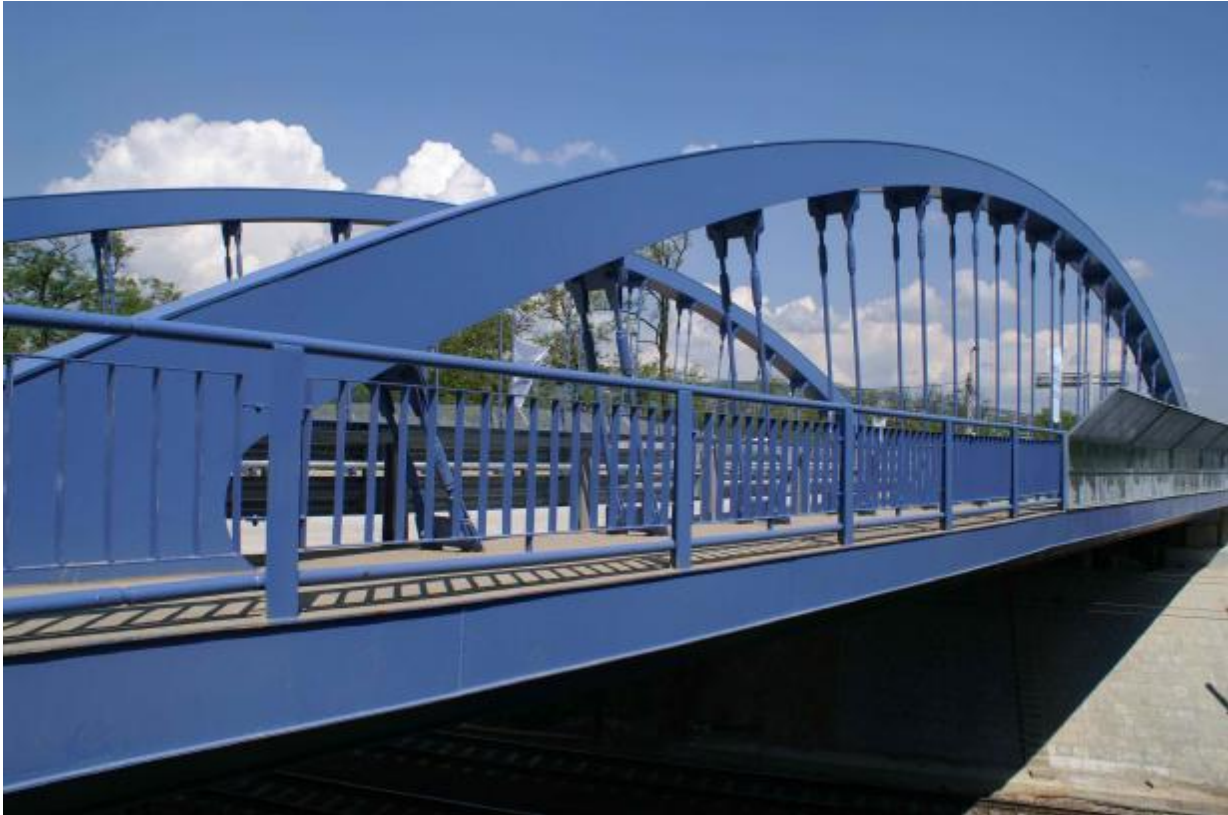
14. kép: az elkészült Balatoni úti felüljáró
