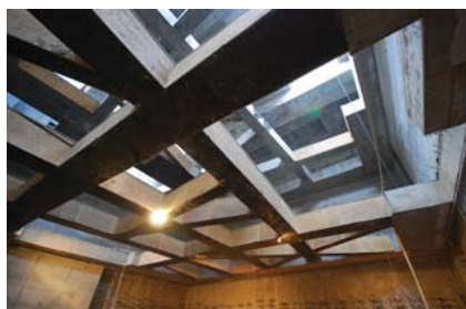
A Szent Gellért téri metró állomás különleges kitámasztó gerendái
