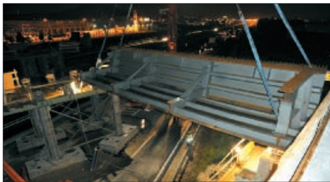
13. kép: M1 autópálya feletti „M-ág” felüljárójának építése: íves szekrénytartó beemelése
