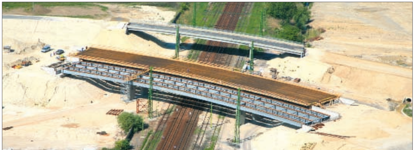
11. kép: M6 autópálya 147 j. híd a Budapest–Pusztaszabolcs vasútvonal felett
