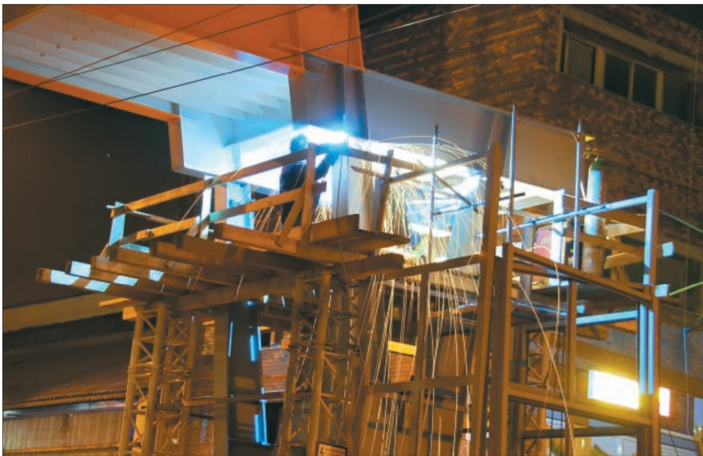
12. kép: A beemelt gerenda keretlábakra helyezése és helyszíni hegesztéssel történő illesztése
