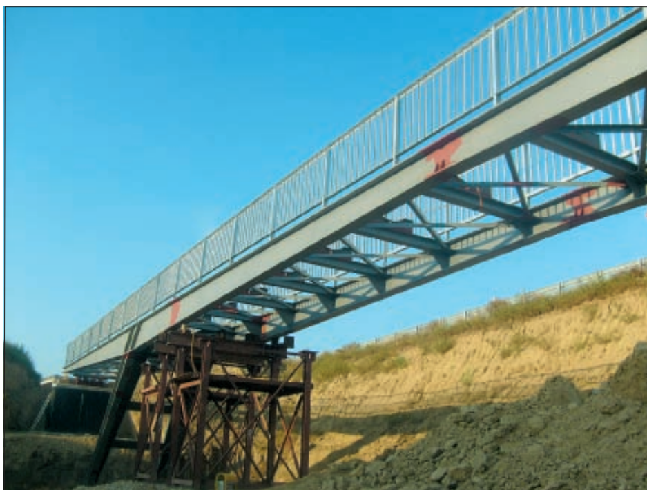
15. kép: Helyszíni szerelés
