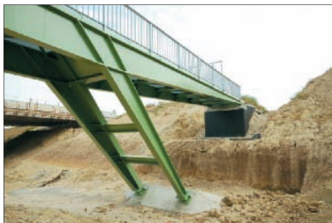
14. kép: Támaszkialakítás: vízszintesen is merevített ferde keretláb
